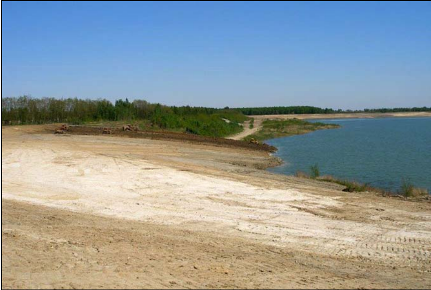
Figure 9.13. Formation of the target profile of the open-pit slopes Source: Kopalnia Siarki Machów w likwidacji
